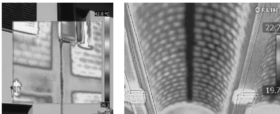
Figura 4.1. Riprese termografiche di facciata (giunto rilevato tra due edifici) ed intradosso di volta; la termografia rappresenta la tecnica più utile e rapida per effettuare una prima ricognizione sugli ambienti ed individuare o riscontrare facilmente le prime informazioni disponibili
