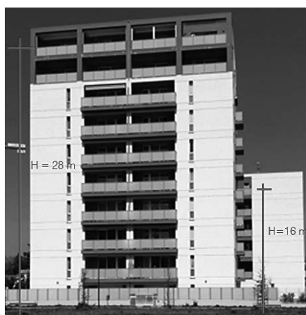
Figura 4.1. Altezza antincendi degli edifici civili secondo il D.M. 30/11/1983
