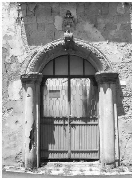
**Figura 7.1.** *Parasta rivestita di calcestruzzo armato*
