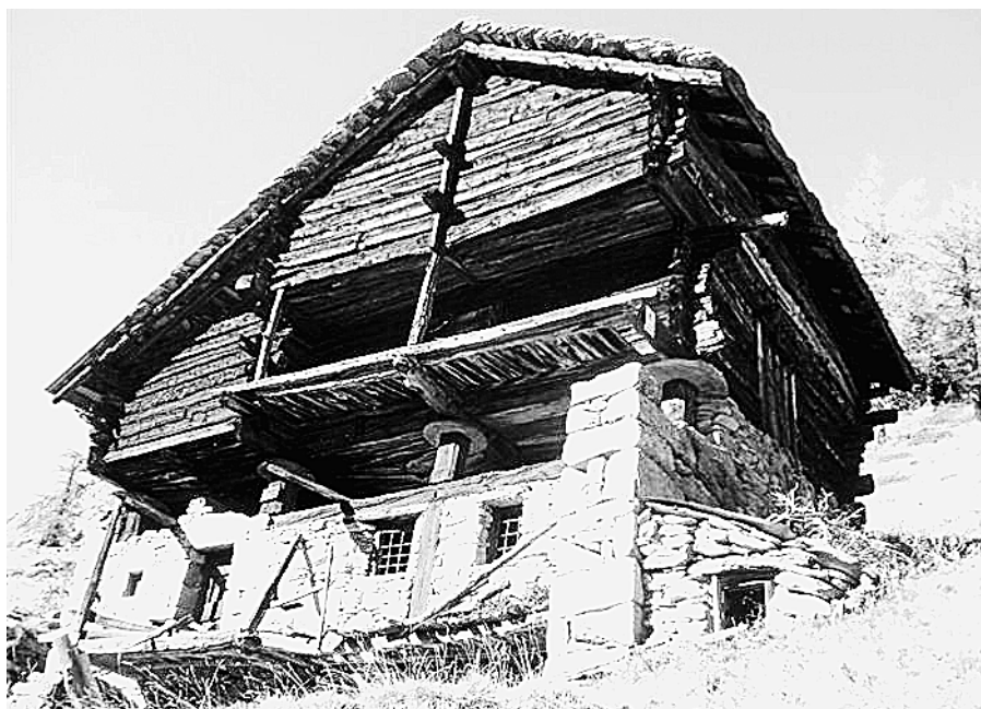
Figura 2.1. Casa Walser della val del Lys: si notano i tipici supporti a fungo con funzione di proteggere la casa dalla risalita dei roditori (fonte Unité des Communes valdôtaines Walser)
