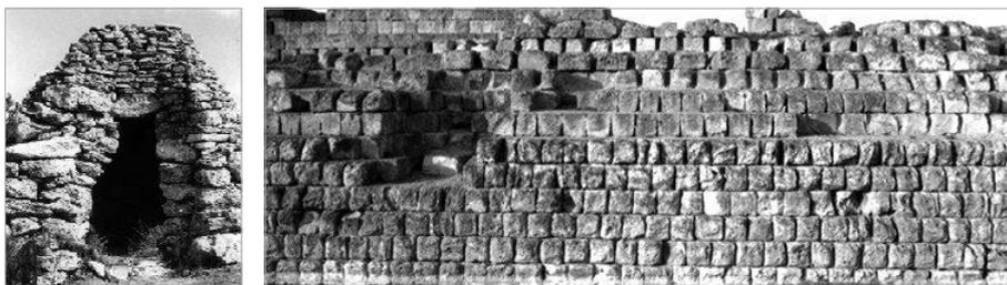
Da notare come nella diversa epoca di realizzazione e destinazione del manufatto cambi anche l'elemento lapideo utilizzato: pietra informe, proveniente da raccolta superficiale, nel ricovero provvisorio, pietra arenaria squadrata nel muro di contenimento
