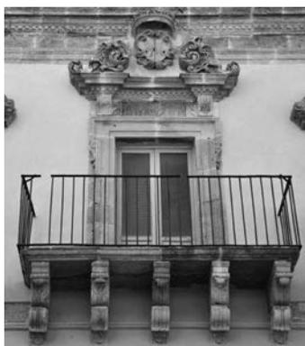
Di seguito si procederà alla verifica agli stati limiti ultimi delle mensole e del lastrone di calpestio da esse portato e alla verifica complessiva al ribaltamento dell'intero balcone. La prima costituisce la verifica di resistenza (STR) mentre la seconda quella di equilibrio di corpo rigido (EQU), così come definite al punto 2.6.1 delle NTC 2018. Per queste verifiche si utilizzeranno i coefficienti  $\gamma_f$  della tabella sottostante.
