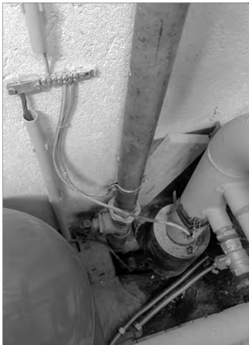
**Figura 5.5.** Collegamento equipotenziale principale
