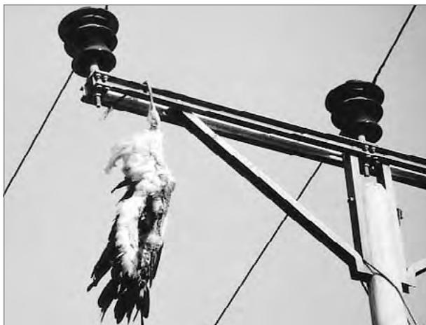
**Figura 5.18.** *Uccello sfortunato che è stato sottoposto a differenza di potenziale (terra – cavo in tensione)*
