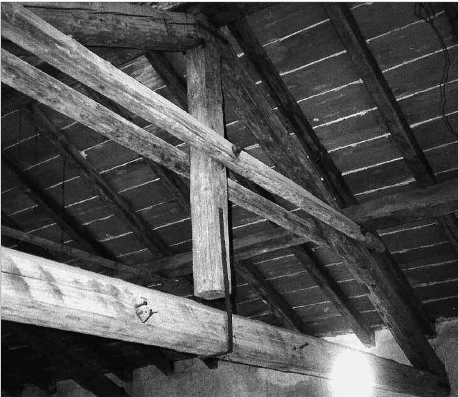
**Figura 3.** Spesso la concezione strutturale dipende da situazioni locali. In questa capriata (copertura in Friuli) è stata prestata grande attenzione per contrastare il sisma. La struttura è infatti chiusa, ben intelaiata e non spingente, specie nello sporto del tetto e nel serraggio delle terzere.
