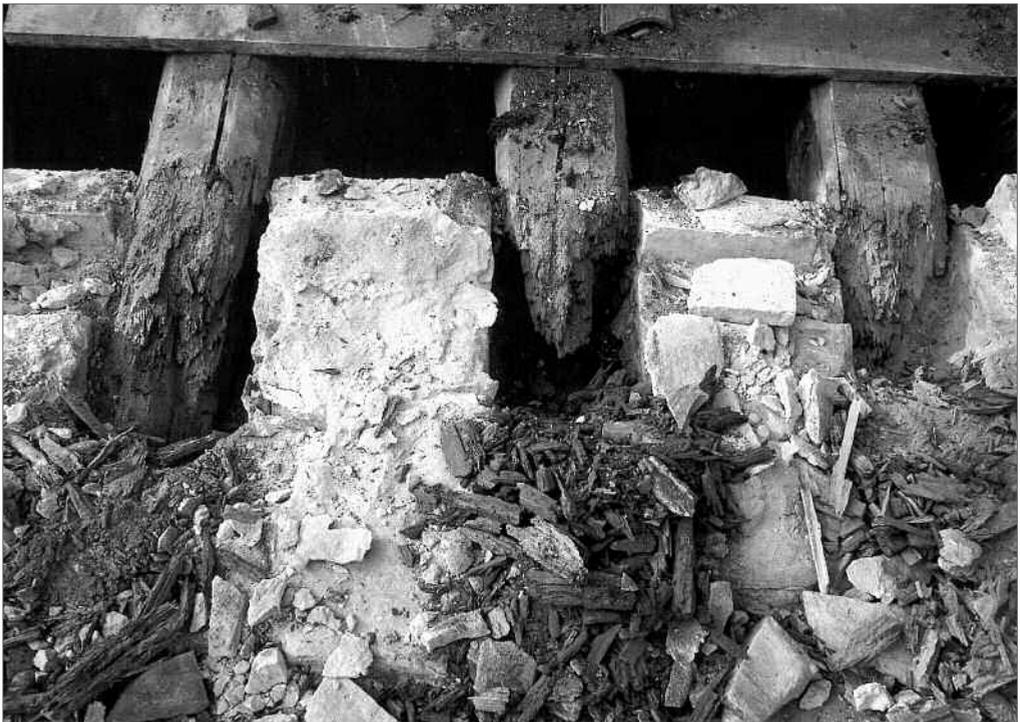
**Fig. 1.6.** Esempio di attacco di carie bruna sulle teste di travi in corrispondenza degli appoggi. Questo è il luogo privilegiato per la formazione di funghi, data la presenza di umidità, specie di risalita o condensa.
