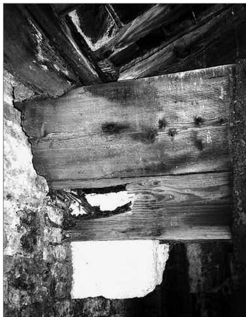
**Fig. 1.8.** L'attacco fungino sulla mensola ha di fatto vuotato l'elemento, facendo abbassare l'intera capriata. Anche la catena è tagliata in corrispondenza dell'appoggio. Si notano batteri fitogeni, anche sul muro, muffe e carie.
