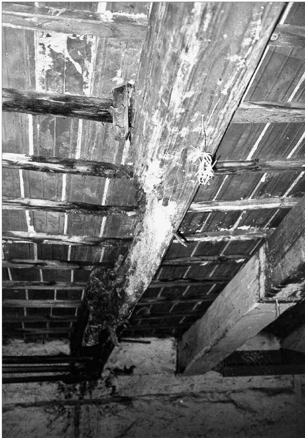
**Fig. 1.2.** A contatto con l'acqua – di infiltrazione in questo caso – i batteri fanno da "apripista" a muffe e funghi cromogeni. Ad essi sopravvivono le cosiddette carie (basidiomiceti e ascomiceti). Infine a completare l'opera, gli insetti.
