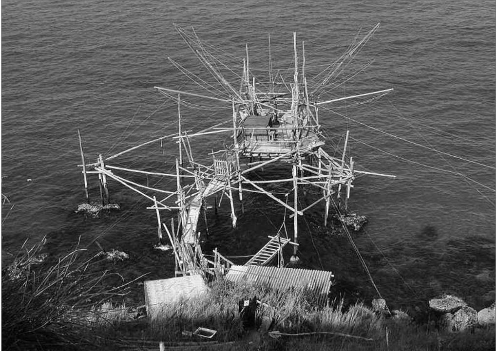
**Figura 5.** Trabucco sul litorale abruzzese. Materiali poveri, ma splendida concezione d'insieme e spaziale per dar vita ad una macchina complessa e funzionale per la pesca. Ciò che non deve andar perduto è proprio l'intelligenza costruttiva, non i pezzi di legno di acacia e di castagno che si possono facilmente sostituire!
